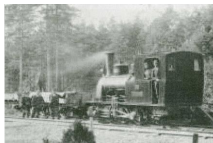
Over: Fra Sandvad i siste del av anleggsperioden da det ble benyttet lokomotiv til transport av grus og materialer.
